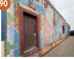
La Casa de la Raza, back wall off E. Montecito St. Untitled (Casa de la Raza back wall) Date painted unknown Manuel Unzueta
